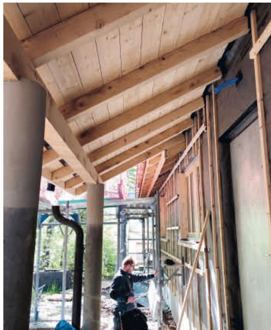
Verlängerung des Dachrandes mittels Sparrenaufdoppelung und sägerohren Tannenbrettern
